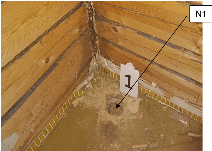
Kuva 1. Rakenneavaus RA1. Materiaalinäyte N1.
