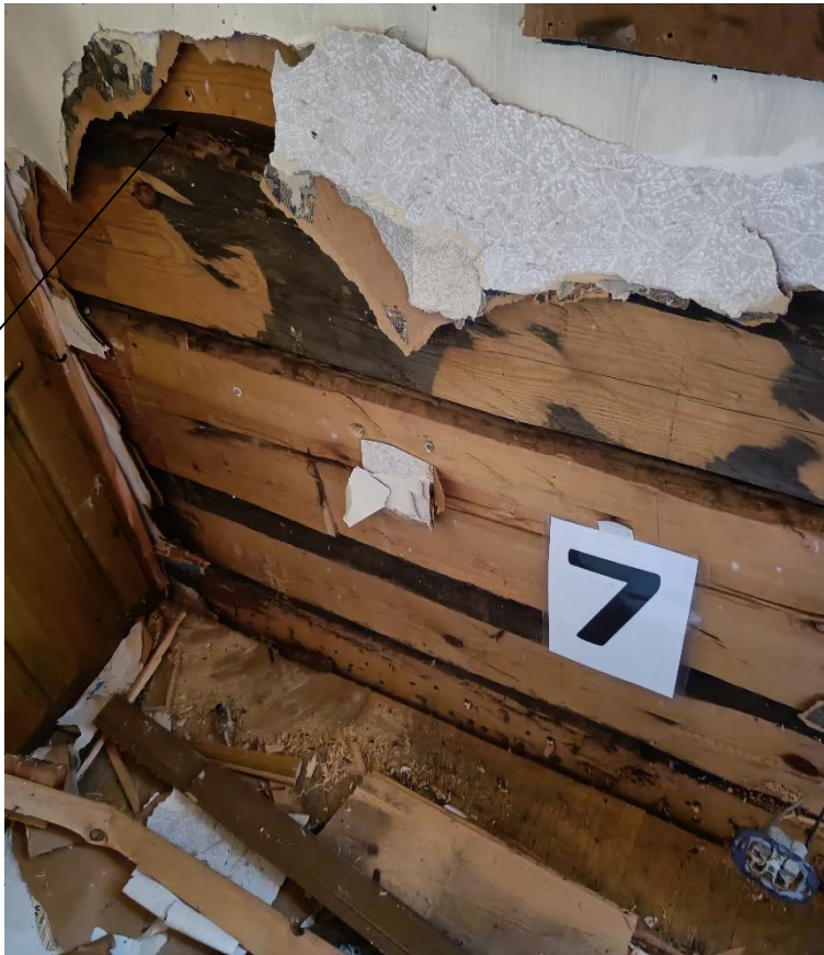
Kuva 10. Rakenneavaus RA7. Materiaalinäyte N7.
