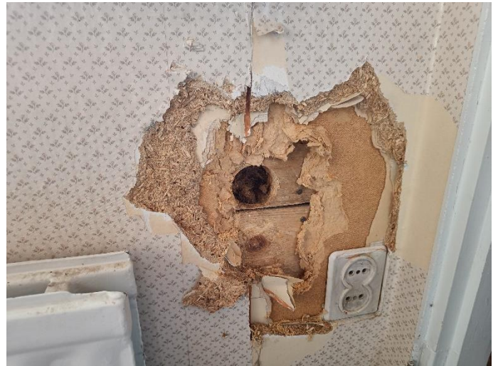
Kuva 14. Rakenneavaus RA9 lähempää kuvattuna.
