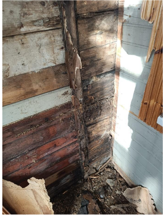
Kuva 9. Rakenneavaus RA6 lähempää kuvattuna.
