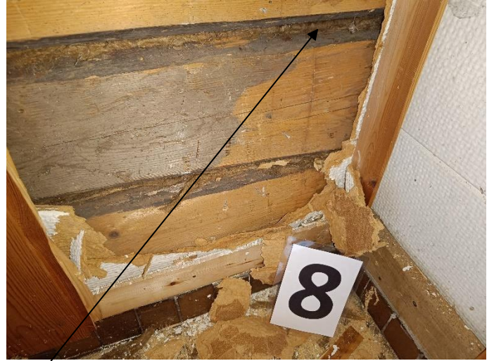
Kuva 12. Rakennusavaus RA8 lähempää kuvattuna.
