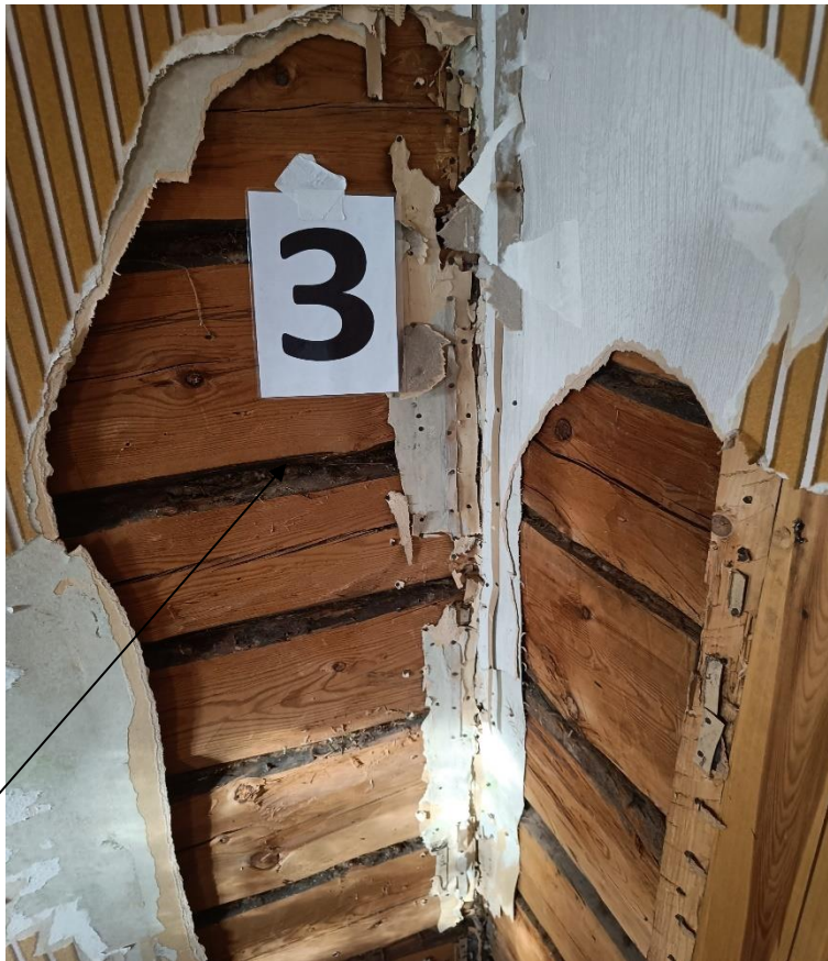
Kuva 5. Rakenneavaus RA3. Materiaalinäyte N4.
