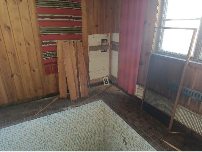
Kuva 11. Rakennusavaus RA8. Materiaalinäyte N8.
