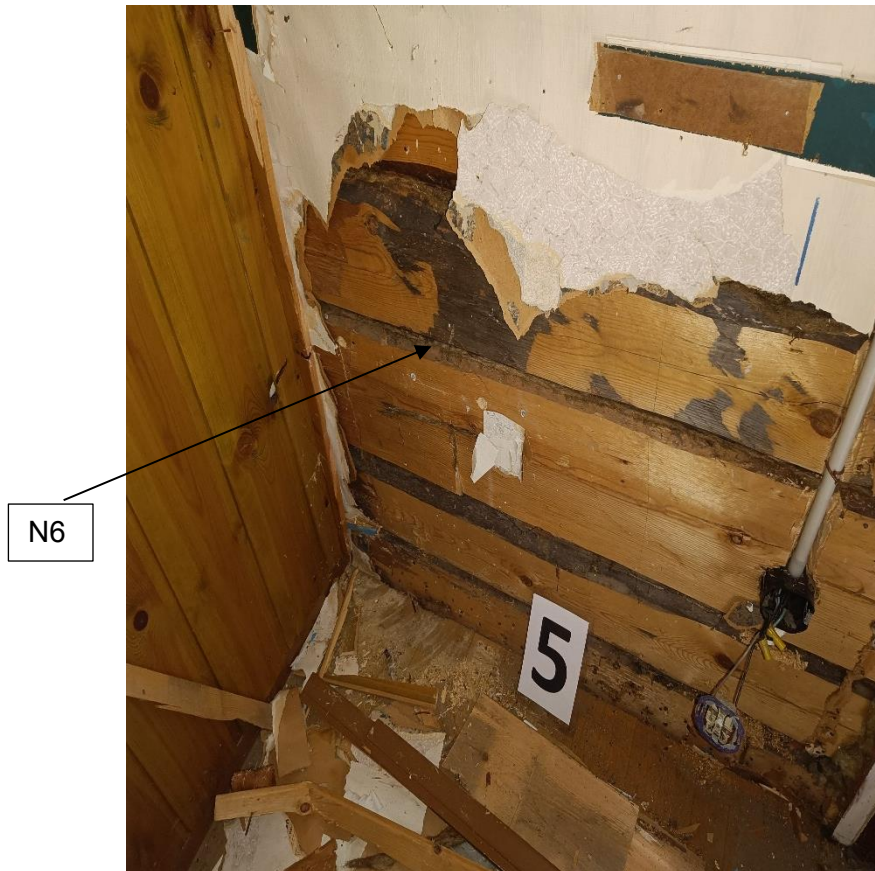
Kuva 7. Rakenneavaus RA5. Materiaalinäyte N6.
