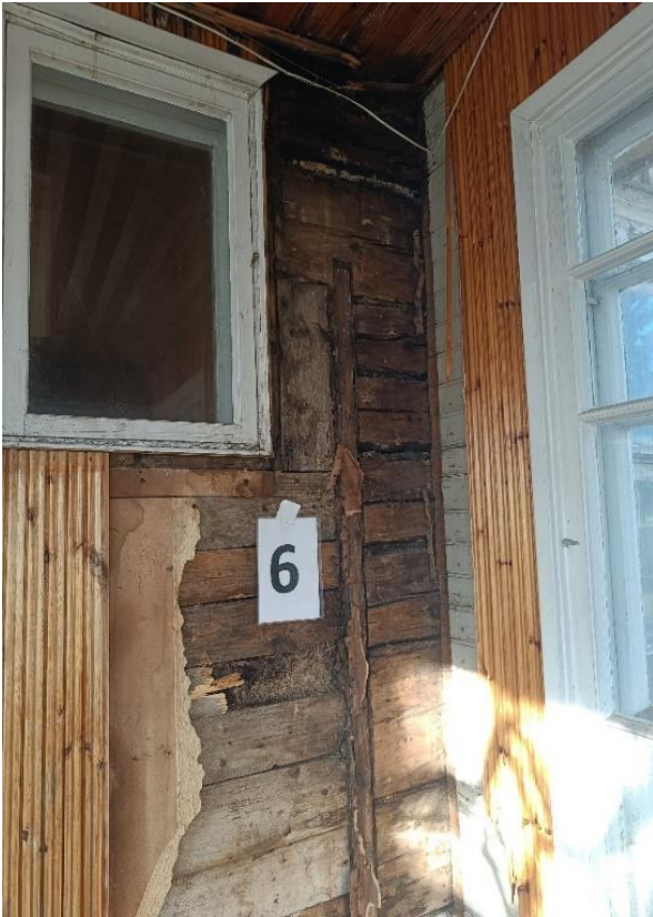
Kuva 8. Rakenneavaus RA6. Materiaalinäyte N6.
