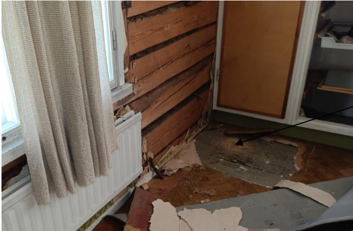
Kuva 3. Rakenneavaus RA2. Materiaalinäyte N3.
