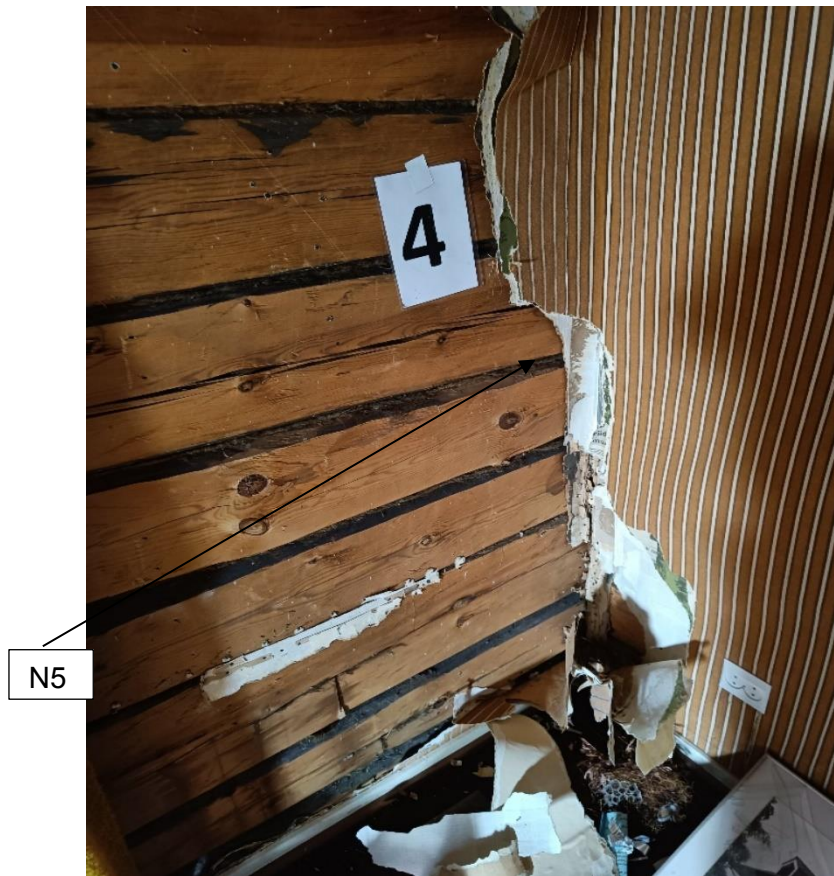
Kuva 6. Rakenneavaus RA4. Materiaalinäyte N5.
