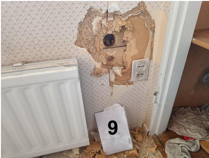
Kuva 13. Rakenneavaus RA9. Materiaalinäyte N9.
